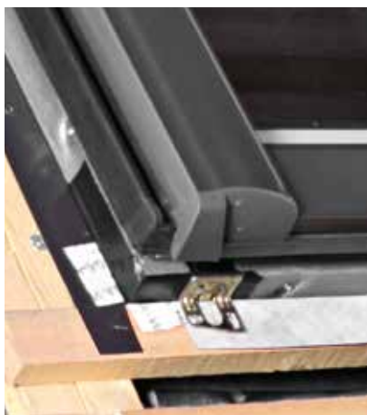
Wykonanie uszczelnienia wodoodporną taśmą dookoła okna
