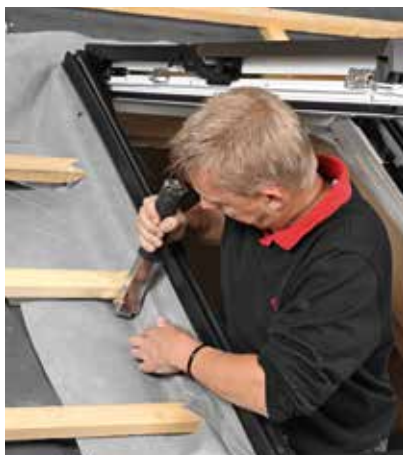
Montaż na łatach montażowych - połączenie wodoszczelne
