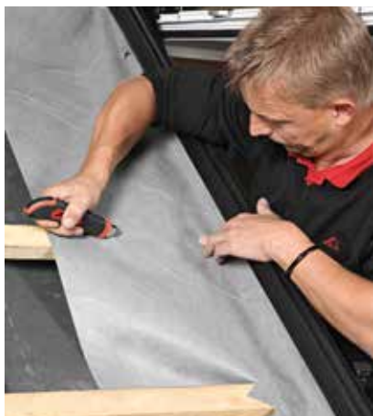
Montaż na łatach montażowych - połączenie wodoszczelne
